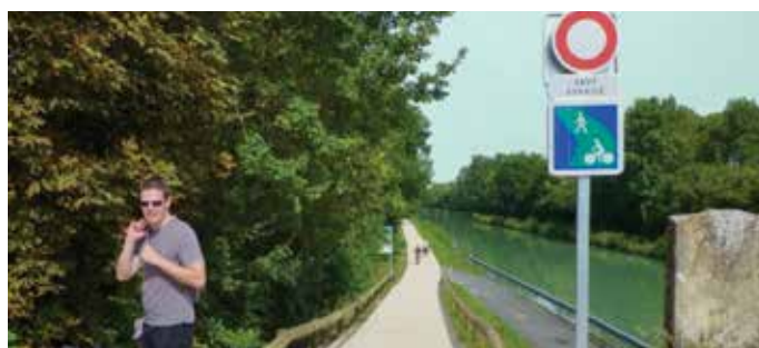
Exemple de voie piétons et vélos en stabilisé
