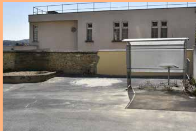
Réfection du mur de la maison des associations qui s'effondrait
