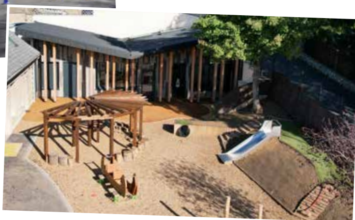
Après les travaux
