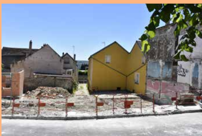
Démolition au 25 Grande Rue de Pissefontaine
