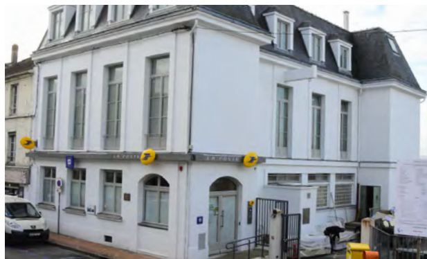
La maison de santé ouvrira début 2020, dans les étages du bâtiment accueillant la Poste.
